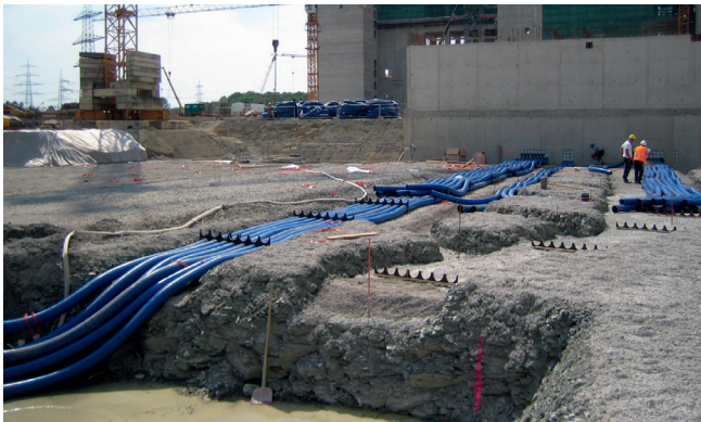
Kabelschutzrohrtrasse für KES-M 150, später mit 6 m Betonüberdeckung
