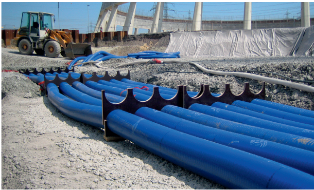
Verlegen der Kabelschutzrohre mit Hateflex 14150
