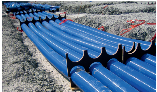
Abstandhalter zur Fixierung und Positionierung von Kabelschutzrohren
