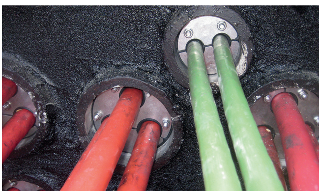
Wszystkie kable zostały po kolei uszczelnione wkładami HRD.
