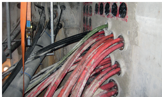
Widok po przebudowie: nowe otwory zostały utworzone poprzez zabetonowanie rur przepustowych w wykonaniu dzielonym oraz zabetonowane zostały przepusty HSI.
