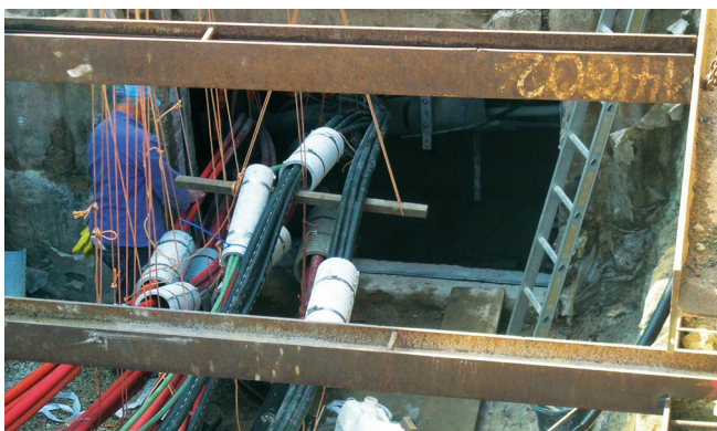
Otwór został utworzony wokół istniejących kabli, zostały one pogrupowane i na nich zainstalowano rury przepustowe w wykonaniu dzielonym.
