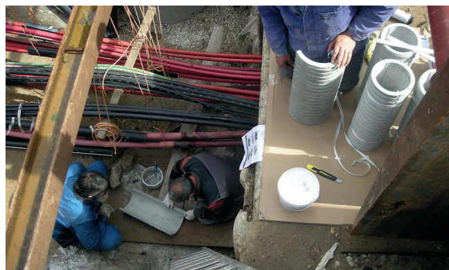
Instalowanie cementowej rury przepustowej w wykonaniu dzielonym FZR-G.
